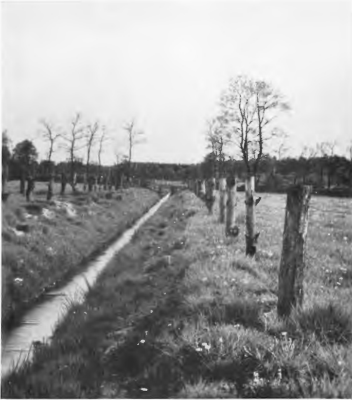
Abb. 6. Ein gleiches Wiesenbächlein im Lippegebiet nach vollzogener Begradigung und „Erfasspflanzung“ an den Ufern.
