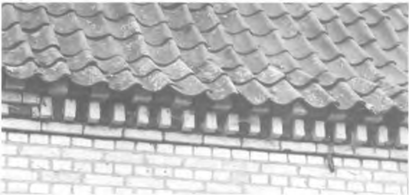
Foto 2 und 3: Unterschiedliche Ziegelbänder
