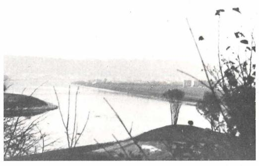
Abb. 3 Naabmündung nach dem Ausbau: Naab (Vordergrund) und Donau kanalisiert, die Ufer fast völlig kahl.
