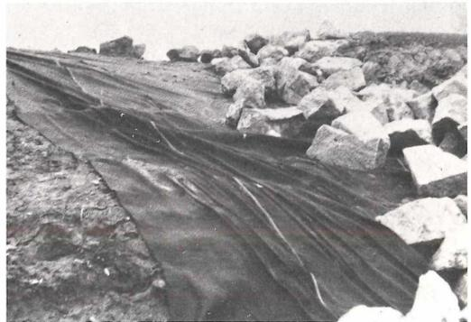
Abb. 5 Aufbau der Uferböschung in der Ausbaustrecke: Erde – Chemiefaser-Matte – Bruchsteine
