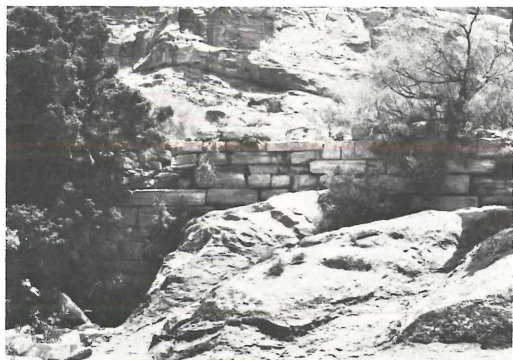
Eine Talsperre 100 m über dem Wadi Sabra besteht aus einer Quadermauer von 14 m Länge, 4,60 m Höhe und 4 m Dicke. Sie konnte mindestens 3,6 Millionen Liter Wasser in einem Stausee ansammeln. Von ihr ging eine Wasserleitung aus, die bis beinahe zum Wadi erforscht werden konnte.
