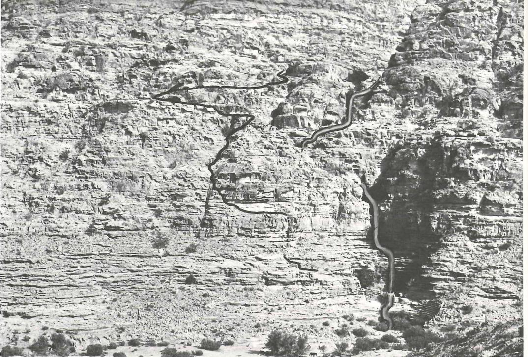
Der Steilhang des Theaterberges von Sabra mit der Wasserleitung (li.) und der Sturzwasserführung (re.). Ganz unten rechts sieht man die erhalten gebliebenen Ränge des Theaters. Die Staumauer ist von unten nicht zu erkennen.
