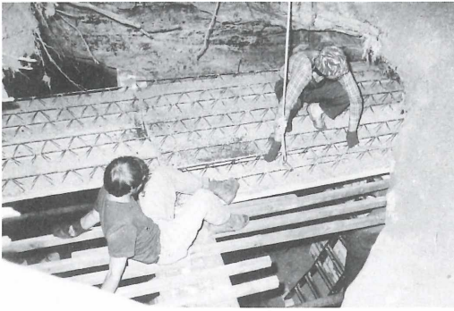
Einbringen der Deckenteile.
