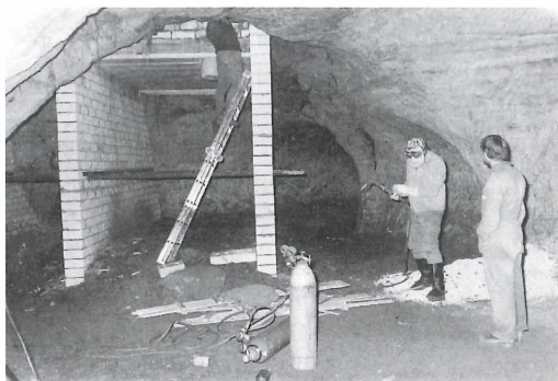
Die fertiggestellte Stützkonstruktion.
