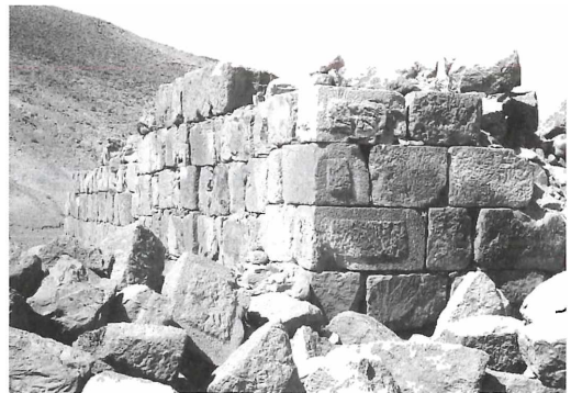
Abb. 9: Detail des Qasr mit geboßen Ecksteinen, die man auch im Versturz erkennen kann.
