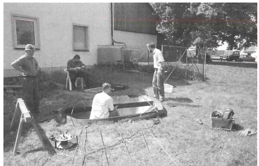
Einbau einer Schalung für die Sicherung des Eingangs zur Klapfenberger Höhle (H 78) am 12. Juli. Foto: Jochen Götz
