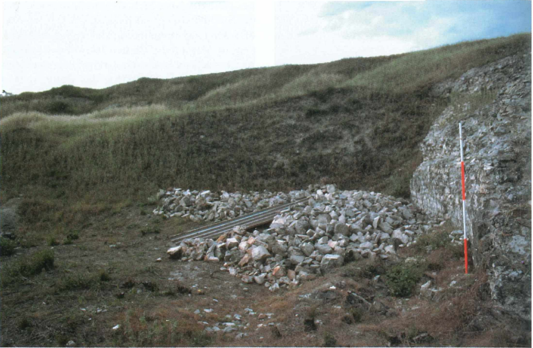
Abb. 27: Stützmauer der cavea zur orchestra hin. Die Sitze vor der Stützmauer wurden bei einem Umbau des Theaters abgebrochen.
