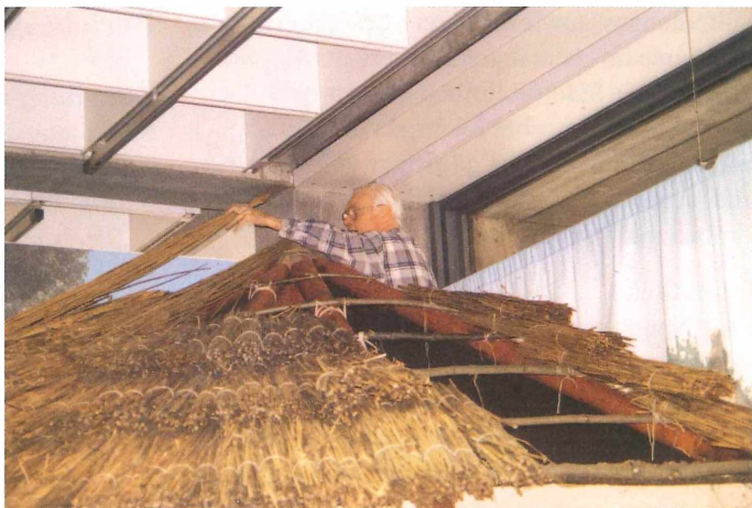
Abb. 3: Dachdecken im neuen Museumsraum West- und Zentral-Afrika.
