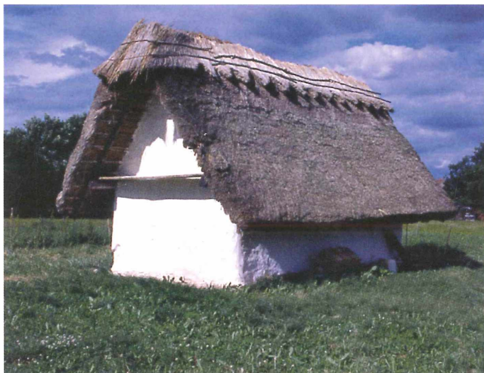
Abb. 24: Das Haus nach der Fertigstellung des Krüppelwalmes an der Westseite. Foto: J. P. Zeitler.
