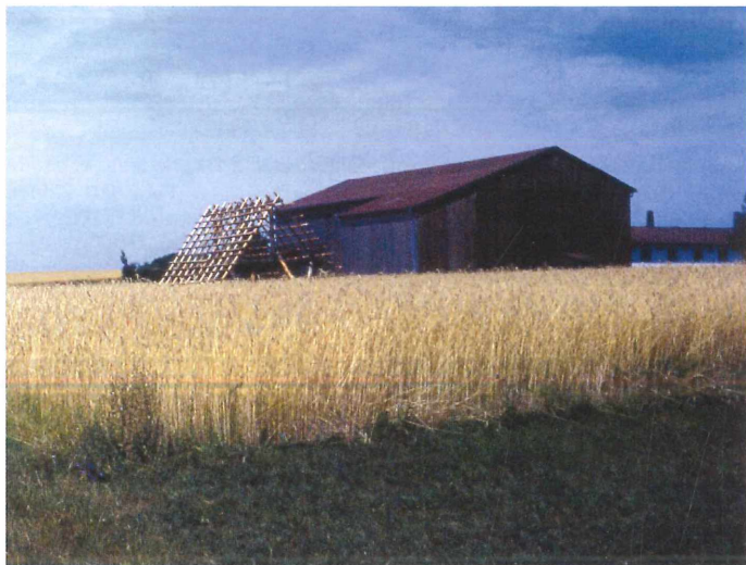
Abb. 12: Das Haus im Rohbau inmitten des Roggenfeldes zur Strohgewinnung. Foto: J. P. Zeitler.
