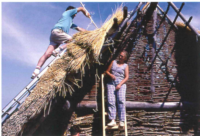
Abb. 16: Nähen der aufgelegten Bündel gegen die Dachlatten und die bereits fertig gestellte Dachhaut. Foto: J. P. Zeitler.
