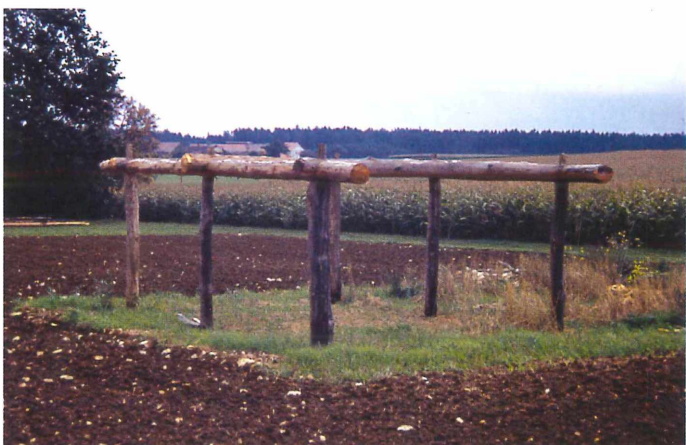
Abb. 7: Das fertige Gerüst aus Pfosten und Pfetten im Verband.
