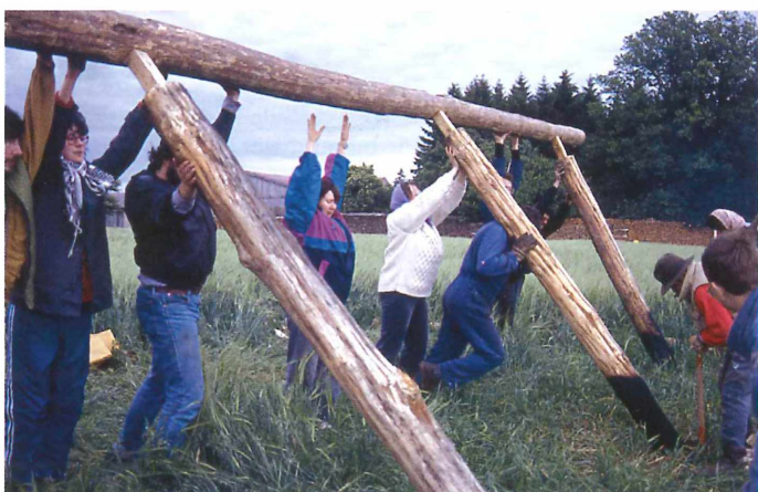
Abb. 6: Aufrichten der Pfosten der Südseite des Hauses. Foto: S. Wegmann.
