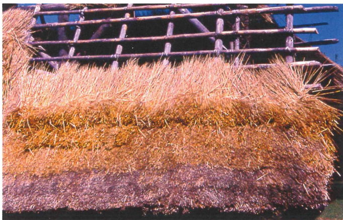
Abb. 15: Die aufgelegten Strohbindel zum Vernähen. Foto: J. P. Zeitler.
