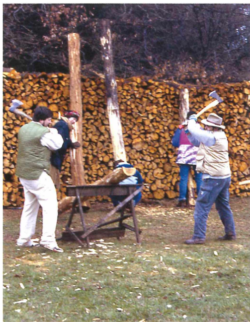
Abb. 3: Zurichten der Verbindungen mit dem Beil.
