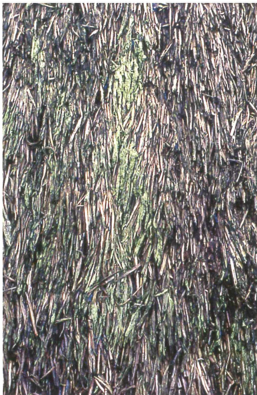
Abb. 23: Moosüberwachsene Stellen im Dach an der Nordseite. Foto: J. P. Zeitler.
