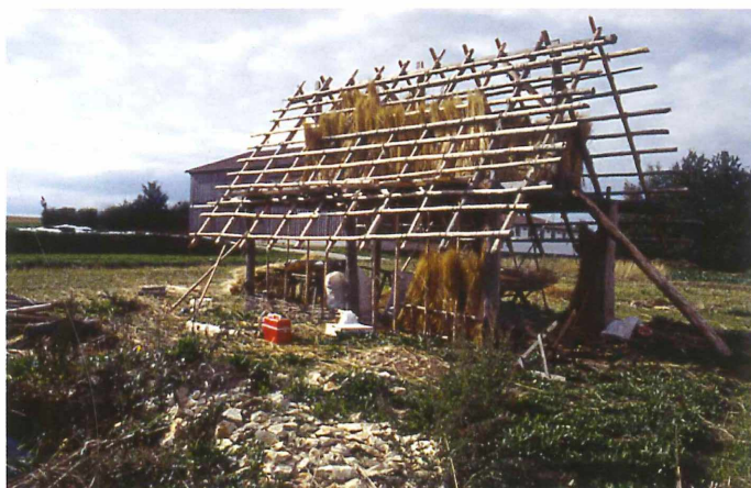
Abb. 9: Der Holzrohbau des Hauses mit Rofen und Dachlattung.
