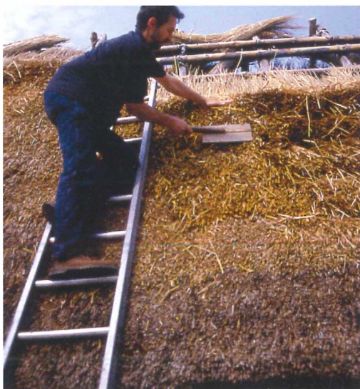
Abb. 17: Schlagen der genähten Deckung in den Bund. Foto: J. P. Zeitler.
