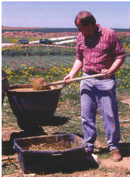
Abb. 20: Teigknetmaschine zum Mischen des Lehmverputzes. Foto: J. P. Zeitler.
