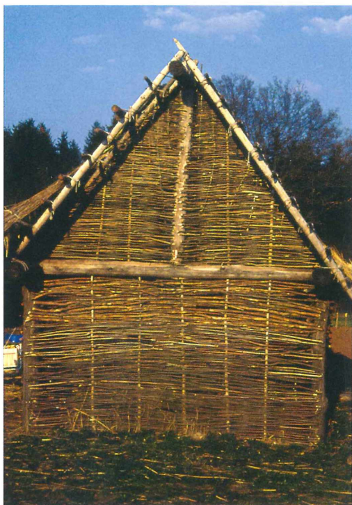
Abb. 11: Die fertig geflochtenen Wände. Ansicht der Westseite des Hauses. Foto: J. P. Zeitler.
