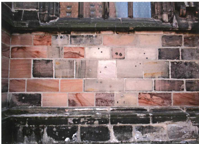
Abb. 6: Verschiedene Burgsandsteine an der Sockelmauer.
