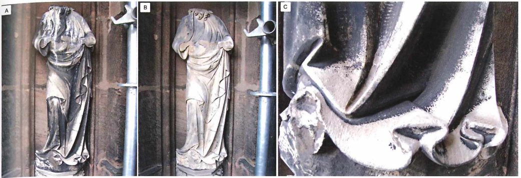
Abb. 8: Figur aus Kelheimer Kalkstein. A: Die Figur im originalen Zustand, mit Verschmutzungen und Rauchgaskrusten. B: Die Figur nach einem Reinigungsversuch mit Krustenausdünnung. C: Detailaufnahme der Figur mit typischem Verwitterungsverhalten, die exponierte Seite ist weiß verwittert, im Wetterschatten hat sich eine schwarze Kruste gebildet.
