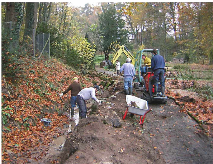
Bachuferbefestigung: Alle Mitglieder helfen mit, das Bachufer neu und hochwasserfest zu gestalten.
