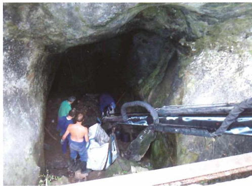
Abb. 4: Die „Bigbags“ werden mit einem Kranausleger aus der Höhle gehoben; Foto: Andreas Eichner, 17.7.2010
