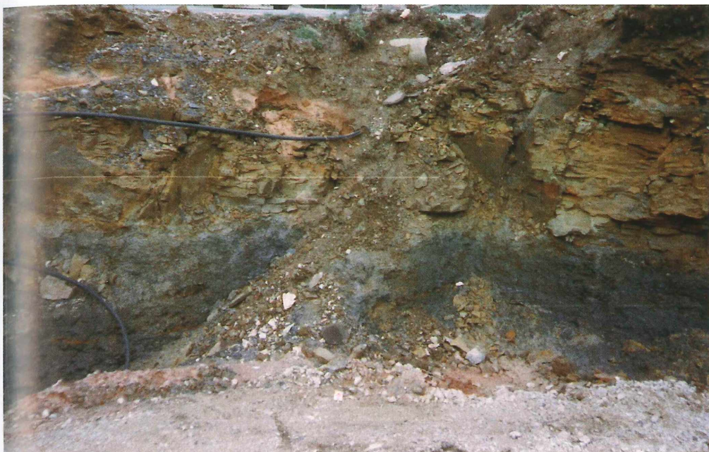
Abb. 1: Baustelle im Ortsbereich von Weihenzell mit Sandsteinen der Benk-Formation
