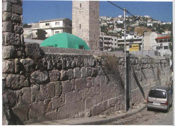
Abb. 12: Südseite von Südwesten 2009
