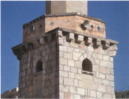
Abb. 16: Minarett-Abschluss von Südwesten
