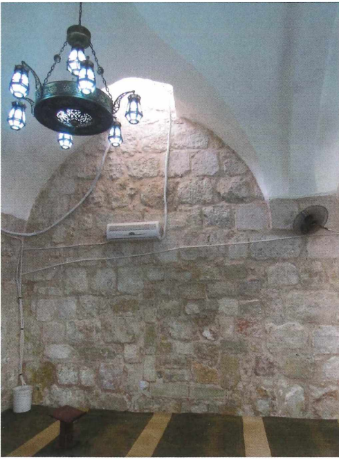
Abb. 3: Westwand mit zugemauertem Eingang
