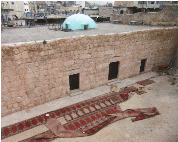
Abb. 4: Nordseite der Moschee von Nordosten 2011
