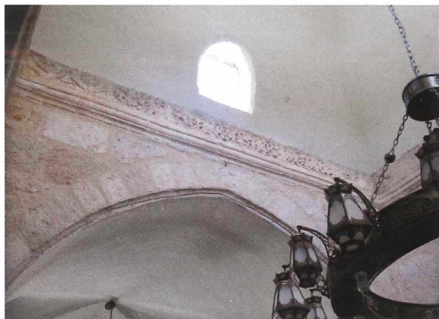
Abb. 10: Mitteljoch mit Spoliengesims
