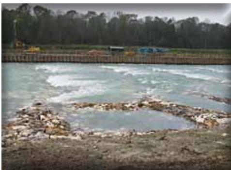
Die „aufgelöste Rampe“ in der Salzach wirkt gegen die weitere Flusseintiefung
