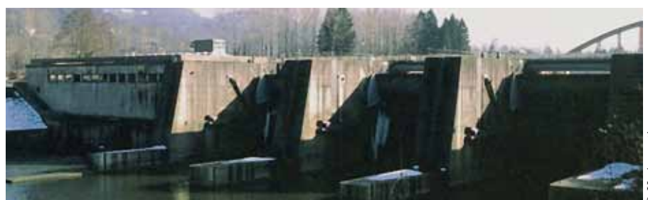
Salzachkraftwerk Urstein seit 1971 in Betrieb
