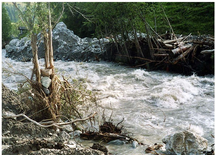
Durch Hochwasser verwüstete Bachufer – Großarl, Juni 2006 (Bild: H. Hinterstoisser).
