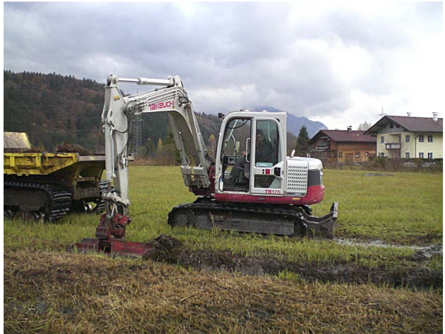
Abb. 5: Nachziehen von verwachsenen Entwässerungsgräben auf einer Streuwiese im Norden des Gebietes (9.11.2006, Foto: C. Arming).
