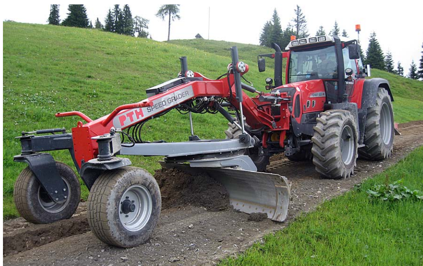
Güterwegerhaltung erfordert den Einsatz moderner Maschinen (Bild: H. Hinterstoisser).
