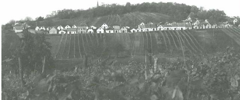
Eine Kellergasse im Weinviertel
