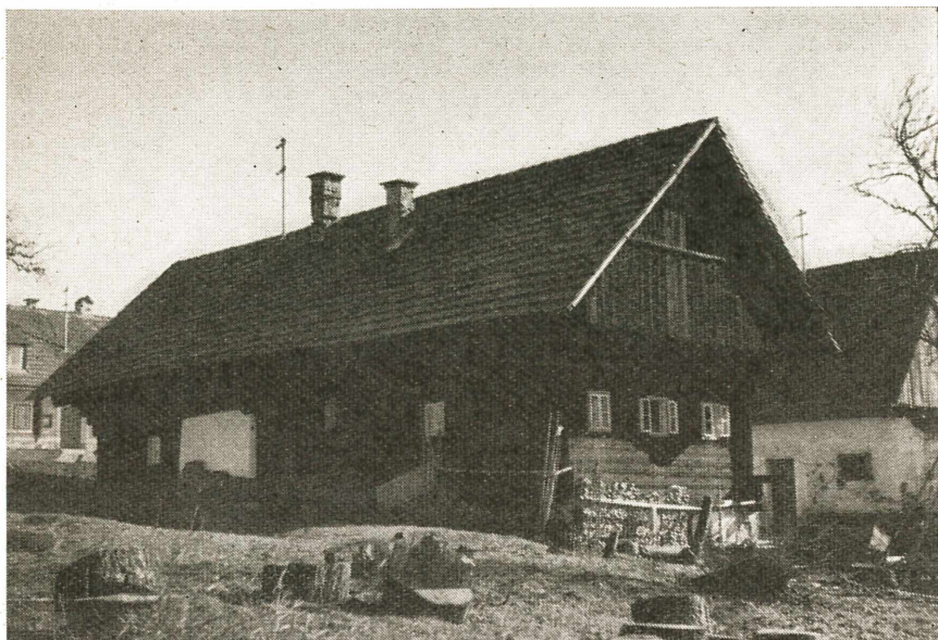
Das Anwesen Stelzer in Rassach vor dem Umbau
