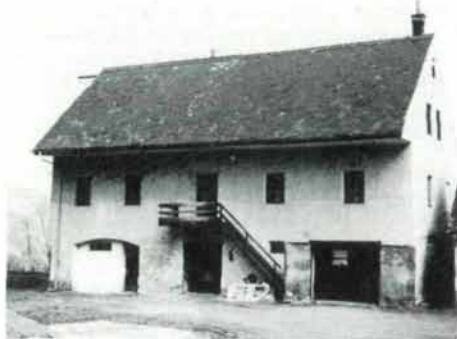
Bestand vor dem Umbau
