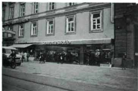
Die ausgeführte Variante mit dem „schwebenden“ Obergeschoß
