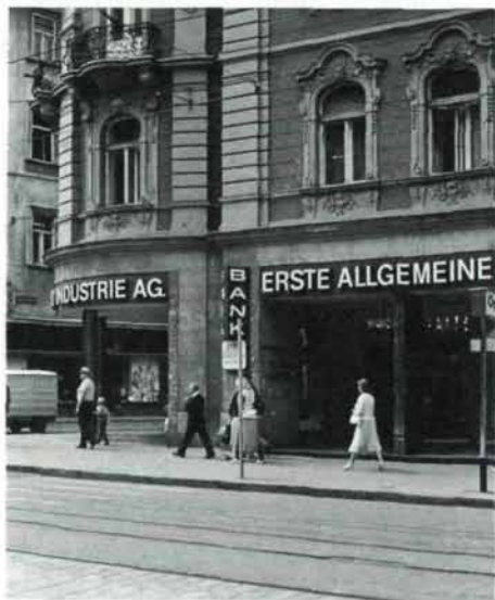
Ursprünglicher Zustand der ausgehöhlten Erdgeschoßzone
