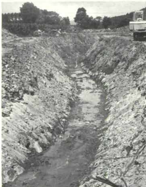
Der neue „Saßkanal“ bei Mettersdorf!
