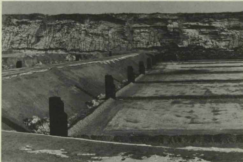
Deponiegasverdichter- und Regelstation.
