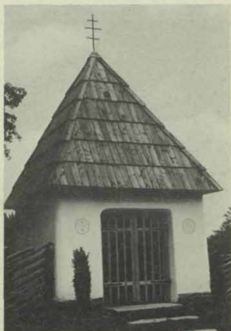
Die Pözl-Kapelle renoviert.
