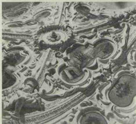
Schloß Friedhofen. Stuckdecke „Kapellenzimmer“
