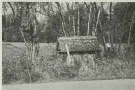
Bauwerke „Hütten“ außerhalb gewidmeter Flächen
