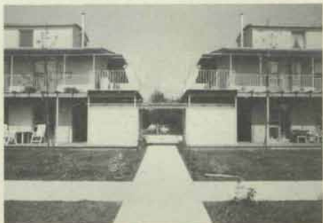
Foto: Siedlung „Holz im Wohnbau“
