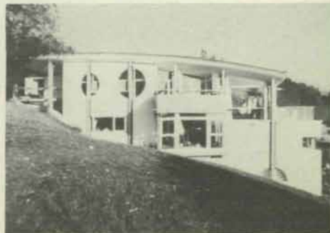
Foto: Wohnhaus Eisenköck
