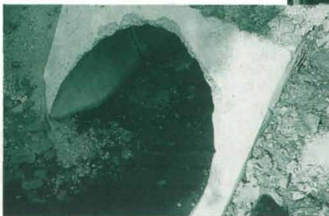
Schutzeinrichtungen müssen nach bestimmten Kriterien gebaut werden, um von den Tieren angenommen zu werden. Ein Durchlaß muß 60 cm haben.
