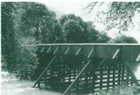
Mödringer Brücke, Frauenberg/Admont
