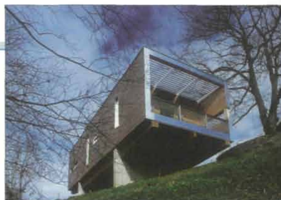
Gästehaus Eichmugl, Admont, Arch. DI Christian Wöhler, Geramb Dankzeichen 2000 Foto: Verein BauKultur
