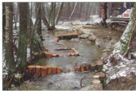
Durch den Rückbau von Wanderhindernissen wurde das Fließkontinuum auf ca. 5,5 km wieder hergestellt.
