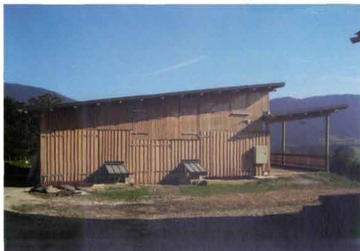
Eine zeitgemäße Bewirtschaftung fordert neue Laufställe.
