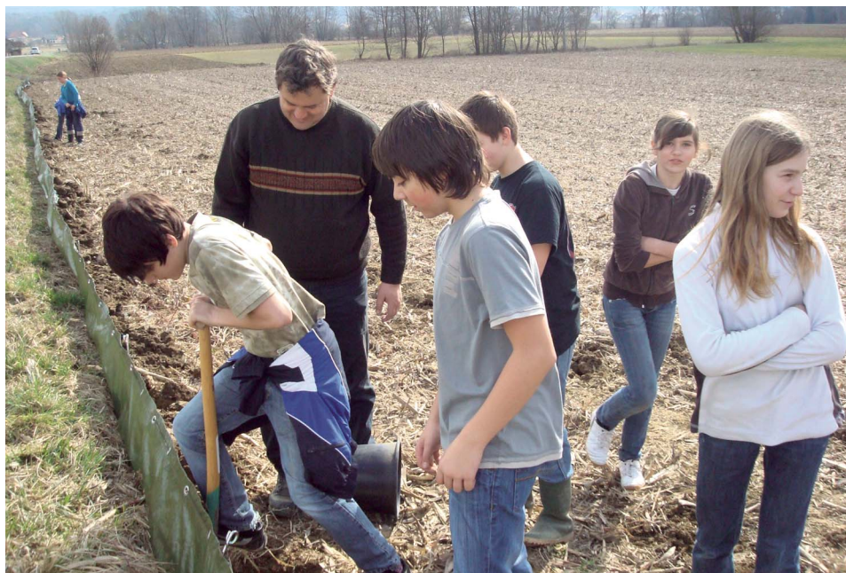
Errichtung eines Amphibienzaunes
