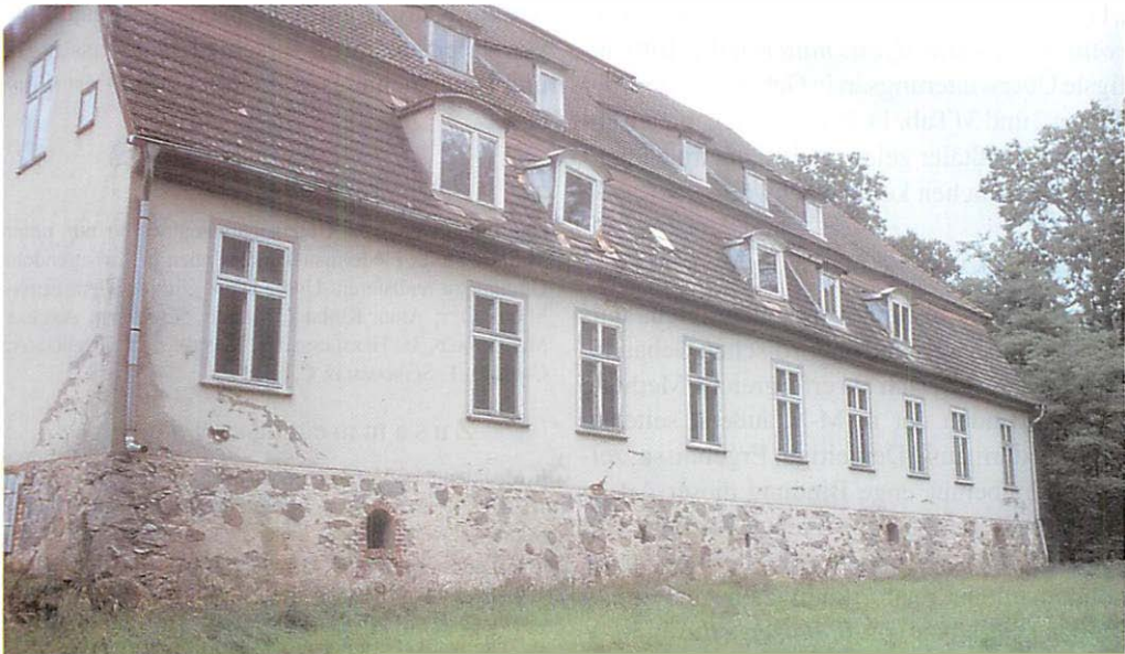
Abb. 5. Gutshaus Nehringen als Beispiel für einen Keller der Kategorie 3. Die Kellerfenster verlaufen ca. 2,5 m schräg nach unten in den tiefergelegenen Gewölbekeller. Aufn.: H. POMMERANZ
