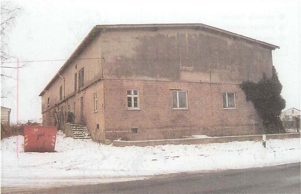
Abb. 4. Winterquartier der Mopsfledermaus ( Barbastella barbastellus ) in einem Stallgebäude in Siemersdorf. Die beiden Kellerfenster sind an der linken vorderen Ecke des Gebäudes zu erkennen. Dieser Keller entspricht der Kategorie 2. Aufn.: H. POMMERANZ
