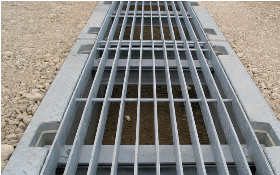
Abb. 8: Gitterrost mit Brückenklasse 1 (Foto: M. KYEK)
