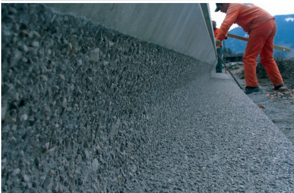
Abb. 4: Leitelement aus der "Froschperspektive" - Lauffläche und Leitwand sind aus Waschbeton, der Überhang ist mit einem zusätzlichen Überstiegsschutz versehen (FOTO: M. KYEK)
