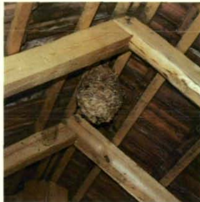
Abb. 4: Das Dachgebälk im Giebelraum zählt zu den bevorzugten Stockstandorten. Foto: J. Eder
