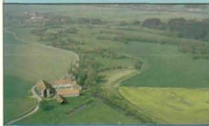
Abb. 5: Die Pram bei Hebertspram mit Hochwasserschutzdamm.
