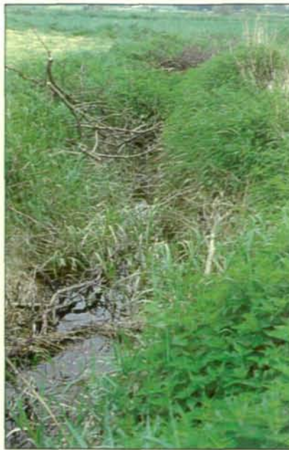
Abb. 5: Eine der Gefährdungsursachen – das Verfüllen mit Astmaterial führt zu einer beschleunigten Verlandung des wasserführenden Grabens.
