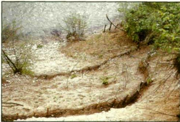
Abb. 3: Rutschhang nach dem Bau der mittleren zwei Flechtreihen.
