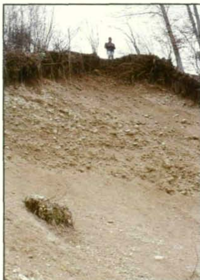
Abb. 1: Blick auf den steilsten Abschnitt im oberen Kantenbereich des Anbruches (März 1983).
