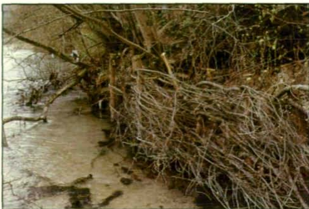
Abb. 6: Die erste Flechtreihe schließt unmittelbar an den natürlichen Uferbewuchs an.
