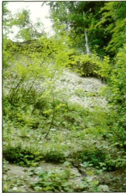
Abb. 12: Die unteren zwei Drittel des Hanges sind bereits gut bewachsen (Sommer 1985).
