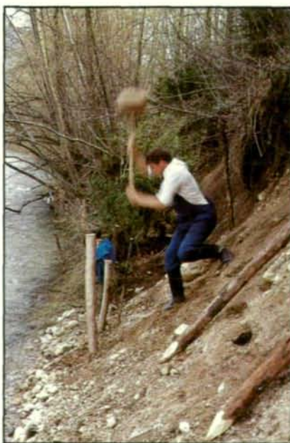
Abb. 4: Beim Bau der untersten Flechtreihe. Alle Fotos: Wimmer/Pühringer
