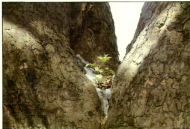
Abb. 4: Die Entfernung der Betonplombe scheint kein Problem zu werden. Abbildungen 1 – 12 vom Verfasser.
