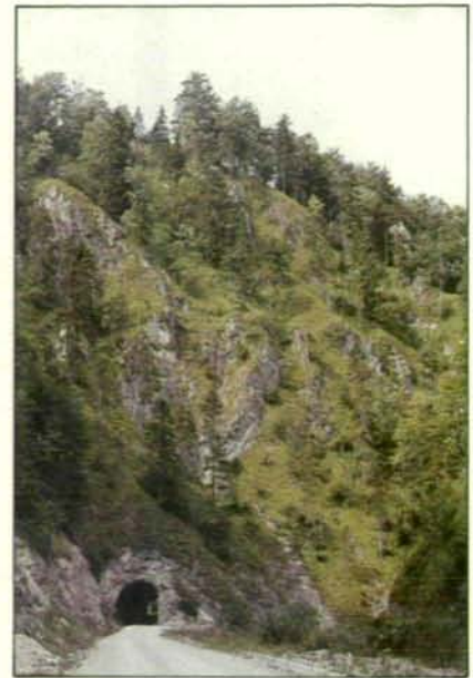
Abb. 25: Die Forststraße benützt die Trasse und Tunnels der alten Waldbahn und steht seit dem Frühjahr 1987 an Samstagen, Sonn- und Feiertagen als Radfahrweg zur Verfügung.
