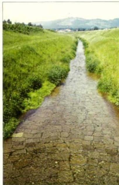
Abb. 6: **Sammelgerinne.** Ein künstlich angelegtes Gewässer, das beiderseits durch Dämme begrenzt ist und dessen Sohle über weite Bereiche mit einem Steinpflaster ausgelegt ist. Durch Sand-, Kies- und Schotteranlandungen und die begrünten Böschungen wird der harte Eindruck etwas gemildert. Die Gewässergüte beträgt größtenteils WGK II-(III).
