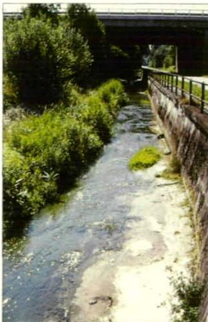
Abb. 5: **Wambach.** Bei der Untersuchung wurde eine Belastung durch Abwässer festgestellt (WGK II-III). Im Mittellauf beeinträchtigt die harte Verbauung der Sohle die Selbstreinigungskraft des Baches empfindlich. Landschaftsästhetisch wirkt sich insbesondere die Ufermauer negativ aus.
