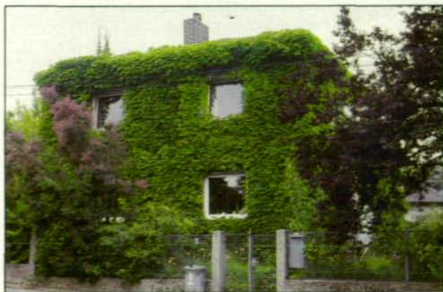
Abb. 1: Ein Haus im grünen Pelz verbessert das Klima der Umgebung und im Haus, schützt die Mauer, gibt Lebensraum für Tiere und ist ein freundlicher Anblick. (Foto: F. Schwarz)
