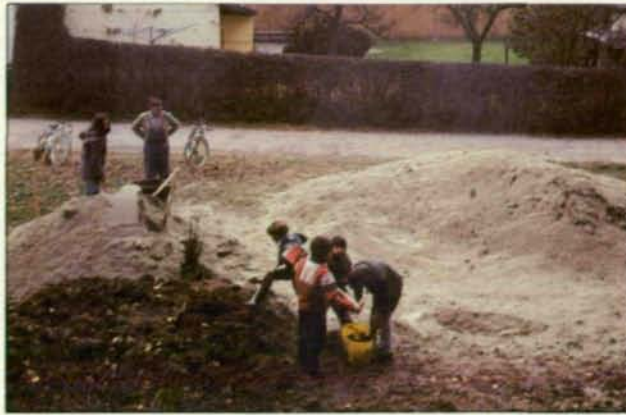
Abb. 4: Die Folie wird mit einem Sand-Erde-Gemisch abgedeckt. (Foto: S. Haller)
