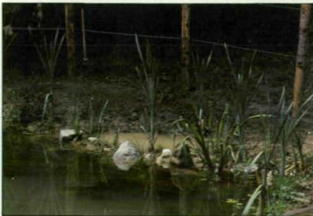
Abb. 5: Modellteich Auberg nach der Fertigstellung: der Boden wurde mit Sand abgedeckt, anschließend mit Wasser gefüllt und bepflanzt (vgl. S. 40). (Foto: F. Schwarz)
