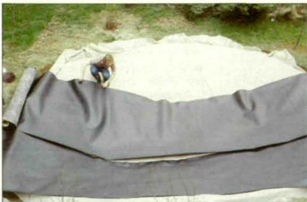
Abb. 1: Die Teichfolie wird in Bahnen verlegt und muß fachgerecht verschweißt werden. (Foto: G. Pfitzner)
