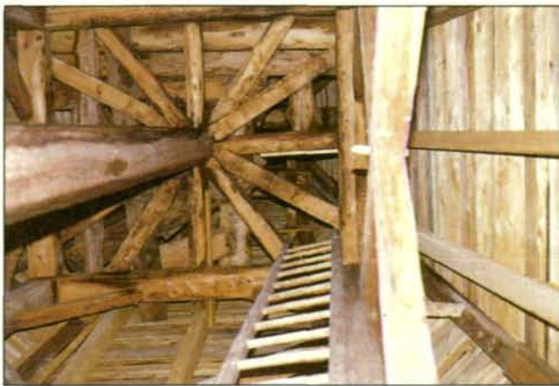
Abb. 3: Manche Fledermausarten (z. B. das Große Mausohr) bevorzugen als Quartier wenig begangene Dachbodenräume. Gerne werden die schwer zugänglichen Dachböden von Kirchtürmen besiedelt. Das Aufspüren von Fledermäusen an diesen Orten ist eine zeitaufwendige und nicht ungefährliche Arbeit, die viel Erfahrung erfordert.
