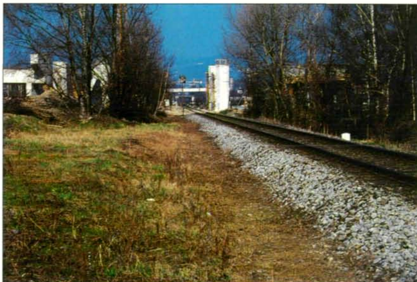
Abb. 9: Temporäres Laichgewässer von Wechselkröte und Gelbbauchunke in einem Entwässerungsgraben zwischen Industriebahn und Autobahn (nahe Wimhölzelstraße). Die Industriebahn besitzt möglicherweise eine zentrale Bedeutung als Korridor für die Wechselkröte in einem hochgradig zersplitterten Lebensraum.
