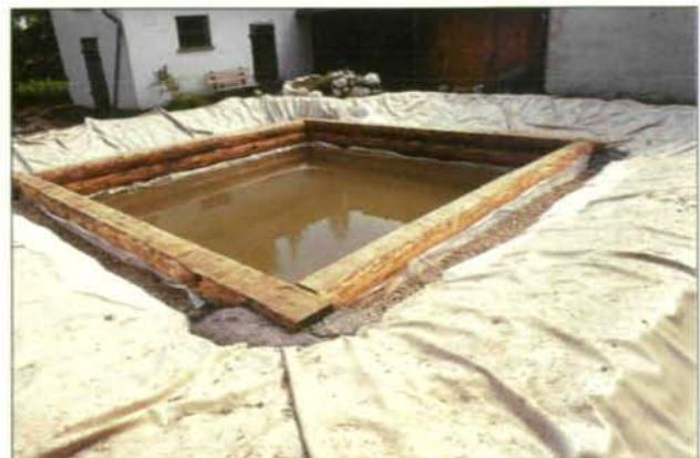
Abb. 3: Beton verhindert das Emporsteigen der Lärchenstämme im Wasser.
