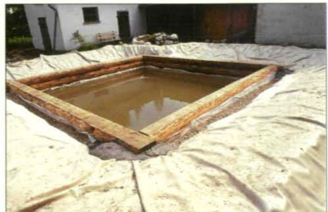
Abb. 3: Beton verhindert das Emporsteigen der Lärchenstämme im Wasser.
