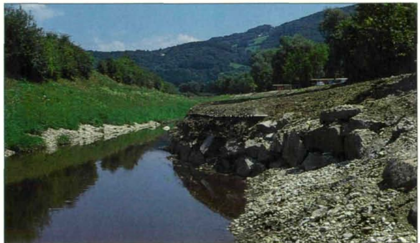
Abb.18: Als Besonderheit wurden an zwei Stellen Steilwände in kombinierter Stein-Holz-Erd-Bauweise hergestellt. Wir haben damit versucht, Brutmöglichkeiten für den Eisvogel anzubieten. Die Zukunft wird weisen, ob sie angenommen werden.
