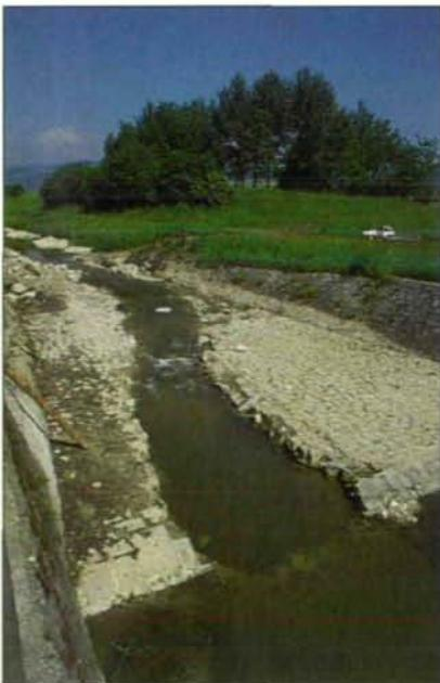
Abb.20: Am Ende der Renaturierungsstrecke wurde eine hart gepflasterte Sohltrappe, welche das Aufwärtswandern von Fischen und anderen Bachtieren stark behindert hat, aufgerissen und eine Niederwasserrinne geschaffen. Dadurch konnte die für die Gewässerökologie negative Kontinuumsunterbrechung aufgehoben werden.
