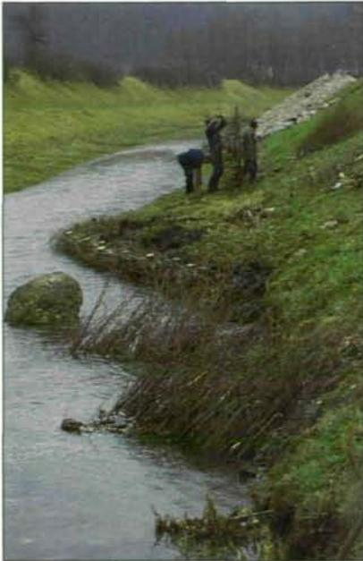
Abb.16: Bauarbeiter bei der Herstellung von Weidenflechtwerk. Einerseits wurden damit Schottervorschüttungen gesichert, andererseits dienen - im Vordergrund zu sehen - schräg in die Uferböschung eingebrachte „Besen“ als Anlandungshilfe für Feinsand und Schlamm, was eine Bereicherung der Biotopvielfalt darstellt.
