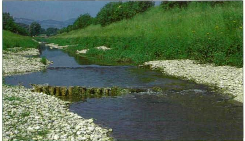
Abb.17: Der Zustand im selben Jahr nach der Fertigstellung: eine im Sohlbereich schräg angeordnete Sohlschwelle bewirkt eine Ablenkung und Durchwirbelung des Wasserkörpers, die unregelmäßig ausgeführten Schottervorschüttungen bringen eine wesentliche Verlängerung der Uferlinie und zusätzliche Flächen für die Vegetationsbesiedlung, die sofort nach Abschluß der Bauarbeiten eingesetzt hat.
