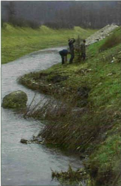
Abb.16: Bauarbeiter bei der Herstellung von Weidenflechtwerk. Einerseits wurden damit Schottervorschüttungen gesichert, andererseits dienen - im Vordergrund zu sehen - schräg in die Uferböschung eingebrachte „Besen“ als Anlandungshilfe für Feinsand und Schlamm, was eine Bereicherung der Biotopvielfalt darstellt.
