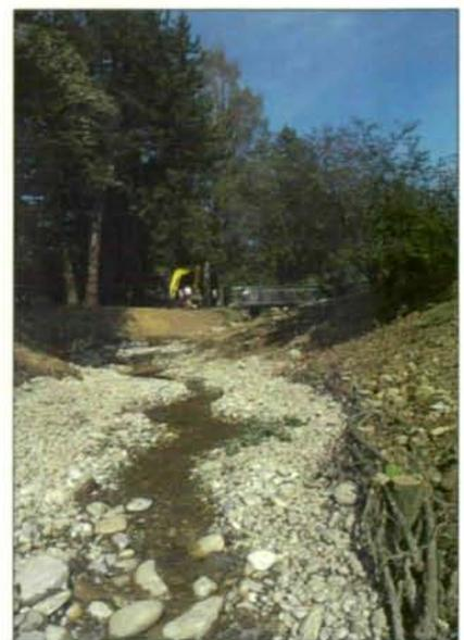
Abb. 23: Nach Abschluß der Renaturierungsarbeiten präsentiert sich der Schießstättenbach in einem gänzlich anderem Bild: Bettaufweitungen, Mäandrierung, geschwungene, vielgestaltige Uferlinie, Einbringung von Schotter, in dessen Lückenraumsystem Wasserorganismen leben können, Weidenflechtwerk zur Ufersicherung, etc. Aus dem Schießstätten „kanal“ wurde somit wieder ein „Bach“.
