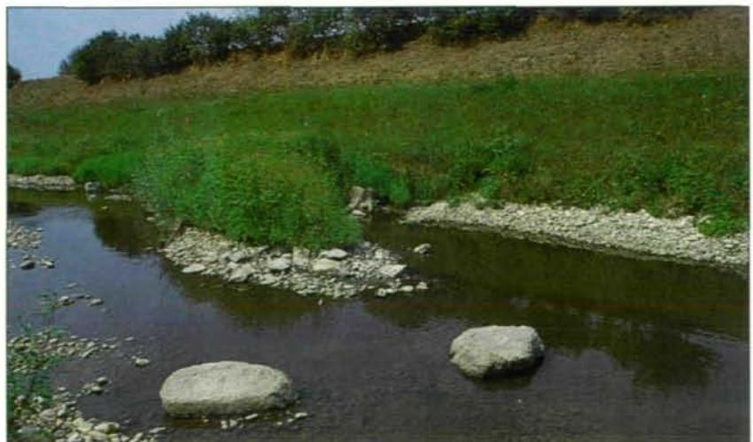
Abb.19: Ein Seichtwasserbereich mit einer Totarmgestaltung: durch halbinselförmig geschüttete Schotterzungen entstanden Laichplätze für Fische, die auch sofort angenommen wurden. Unregelmäßig angeordnete Rundlinge, welche bei Donaubbaggerungen zum Vorschein kamen, dienen als Störsteine und werden gerne als Sitzwarten von Bachstelzen und anderen Wasservögeln angenommen.
