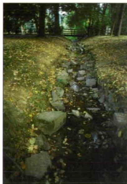
Abb. 22: Der sog. „Schießstättenbach“ im Stadtteil Harbach in Urfahr wurde 1994 vom Gartenamt, dem Tiefbauamt unter Beiziehung der Naturkundlichen Station im Bereich einer Parkanlage auf einer Länge von rd. 500 m renaturiert. Der ursprüngliche Zustand erweckte einen traurigen Eindruck: z.T. verfallene Ufermauern aus eckigen Wasserbausteinen, gepflasterte Sohle und gestreckter Verlauf.
