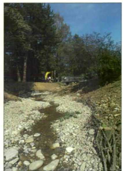
Abb. 23: Nach Abschluß der Renaturierungsarbeiten präsentiert sich der Schießstättenbach in einem gänzlich anderem Bild: Bettaufweitungen, Mäandrierung, geschwungene, vielgestaltige Uferlinie, Einbringung von Schotter, in dessen Lückenraumsystem Wasserorganismen leben können, Weidenflechtwerk zur Ufersicherung, etc. Aus dem Schießstätten „kanal“ wurde somit wieder ein „Bach“.
