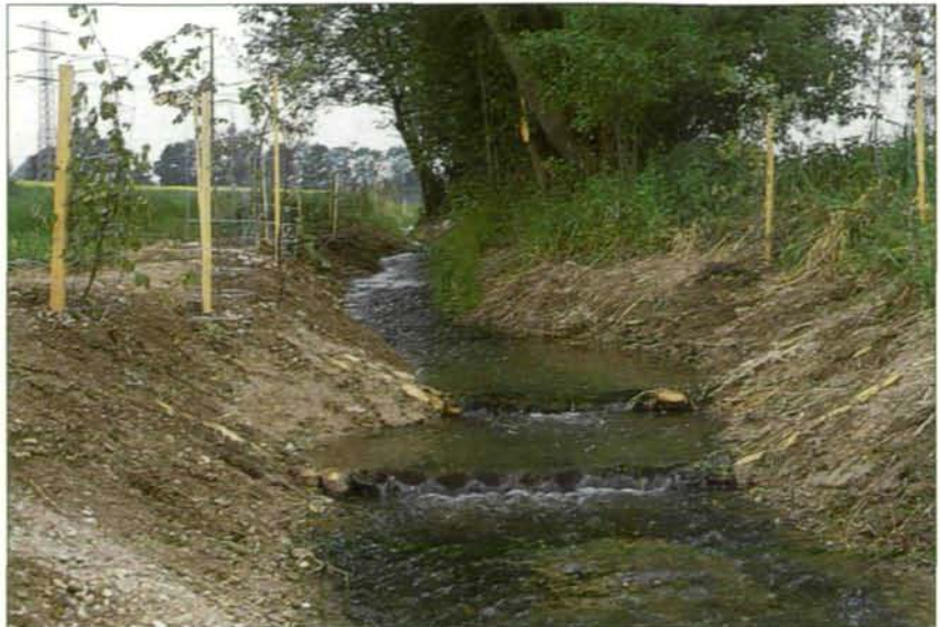
Abb.12: Der Tagerbach kurz nach Fertigstellung der Renaturierungsarbeiten: das Bachbett wurde beträchtlich aufgeweitet, eine doppelreihig angeordnete Sohlschwelle aus Holzpiloten bringt eine Durchwirbelung und Belebung des Wasserkörpers, stellenweise wurde das Ufer mit Weidenflechtwerk gesichert und mit der Pflanzung von bodenständigen Bachgehölzen wird eine Beschattung des Baches erreicht, damit die Verkräutung verhindert wird.
