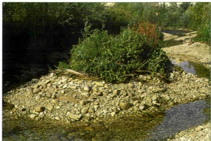
Abb.10: Der Weidingerbach nach den Renaturierungsarbeiten: mit Schottervorschüttungen wurde die Uferlinie neu gestaltet, abgeflacht, verlängert, Alt- und Totarme, Seicht- und Tiefwasserzonen sowie Inseln angelegt. Nach kurzer Zeit haben sich die neuen Flächen mit einer artenreichen Pionierflora begrünt.
