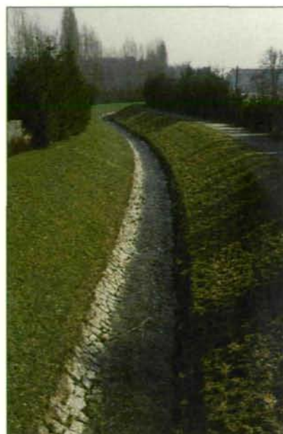
Abb. 1: Gepflastert, begradigt, kanalisiert - gesichtslose Wasserrinnen, die den Namen „Bach“ nicht mehr verdienen: so sehen viele unserer Stadtbäche aus.
